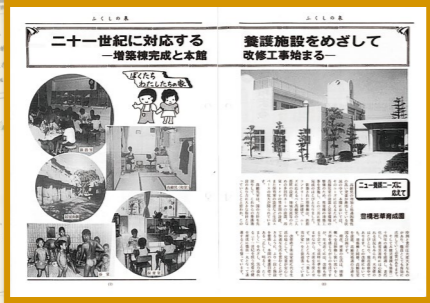
◆1990.10月 第21号 豊橋若草育成園増築棟竣工
