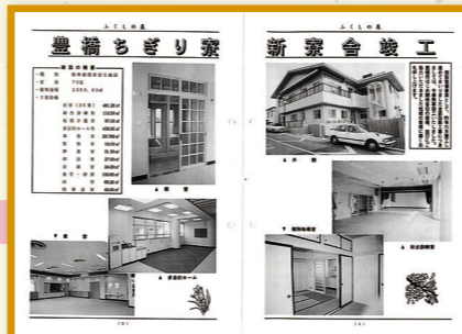
◆1993.4月 第25号 豊橋ちぎり寮新寮舎竣工
